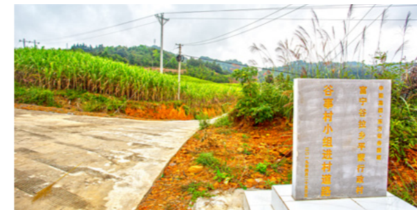
助力谷拉乡平蒙村进村道路硬化
